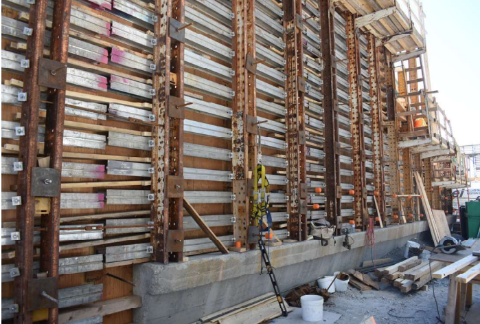
Wall formwork - «de la commune» Bridge
