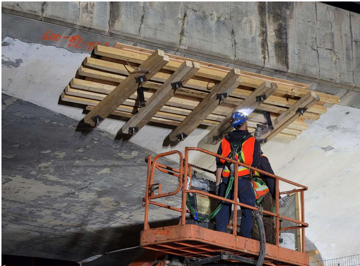
Coffrage pour réparation du tunnel
