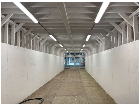
Structure pour circulation accès temporaire
