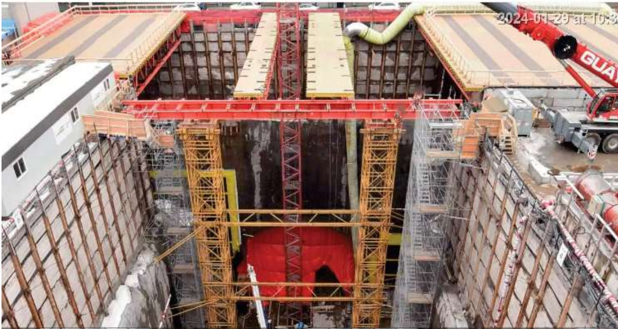
Structure d'abri d'hiver, étalement EFCO et poutres PERI
