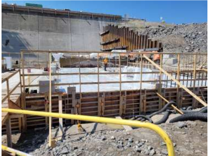
Coffrage dalles et radier et travaux de fondation
