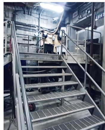
Mise aux normes escaliers de secours
