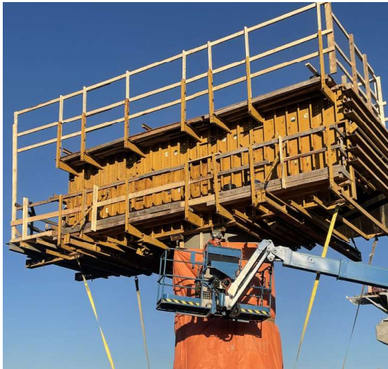
Coffrage EFCO chevêtre «Cross-Country»
