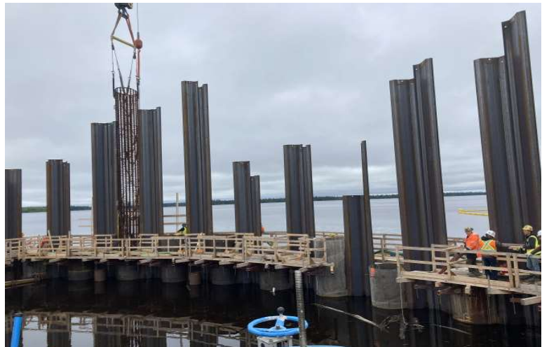
Consoles et coffrage travaux maritimes
