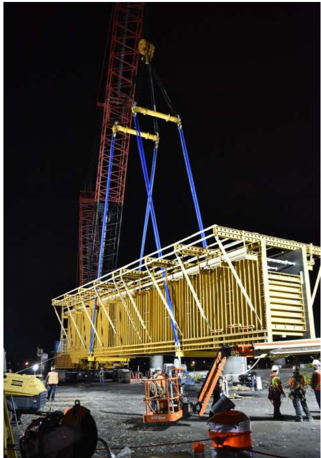
Levage chevêtre double EFCO
